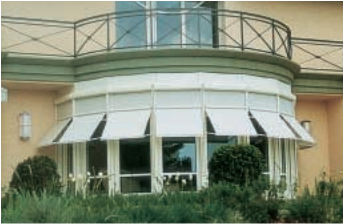
Durch den variablen Ausstellpunkt der Ausstellarme stehen viele Beschattungsmöglichkeiten offen.
